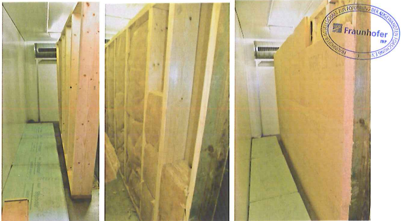
Abbildung 3: Verschiedene Schichten der Probewand.
