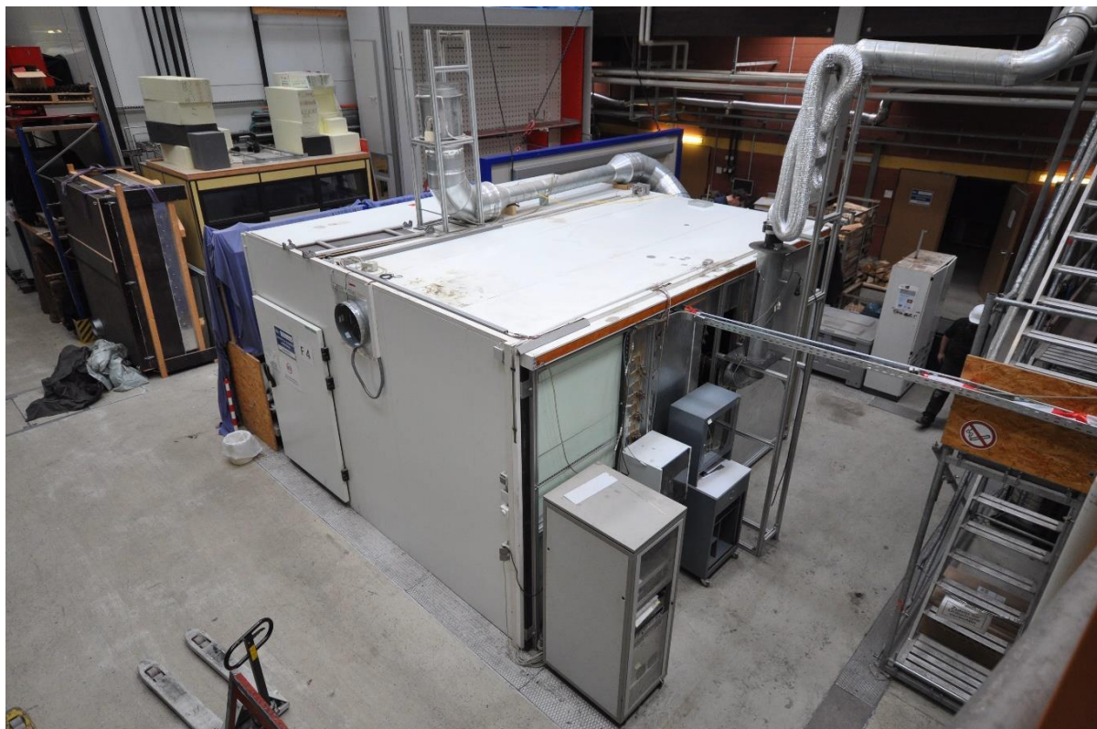
Rysunek 2: Techniczne urządzenia badawcze (pomieszczenie kalorymetryczne) do określania bilansów energetycznych.
